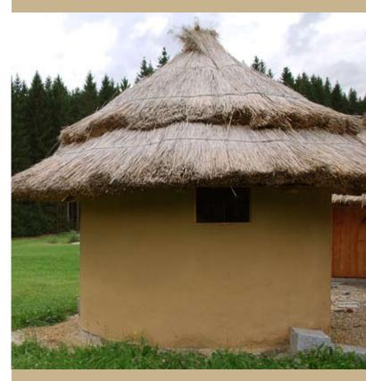
Das für das Dach verwendete Gras wird in kleinen Bündeln zu langen "Ketten" gebunden, die dann ihrerseits später übereinander auf das Gerüst des Daches gebunden werden. Die Wände der Hütten werden ohne Zuhilfenahme eines Baugerüstes Schicht um Schicht aus Lehm aufgebaut, jeden Tag ein wenig mehr. Das erfordert allerdings ein sehr trockenes Klima, damit der Lehm auch von einem Tag zum anderen trocknen kann.
